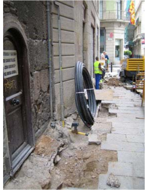
FOTO 2. Vista general de l'obra al carrer Sots-Tinent Navarro
