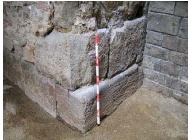
FOTO 6. Muralla romana del costat on es veu la filada corresponent a la pedra localitzada
